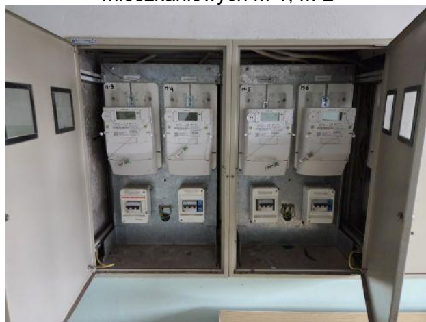
Fot. 20 Liczniki i Wyłączniki główne tablic mieszkaniowych zlokalizowane
