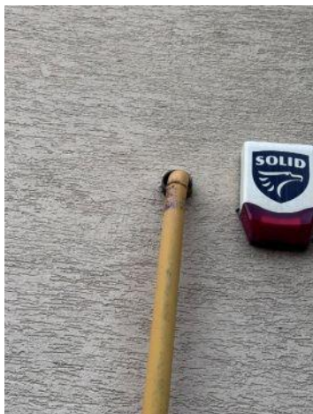
Fot. 27 Przepust rury gazowej nie wypełniony masą uszczelniającą – do uzupełnienia
