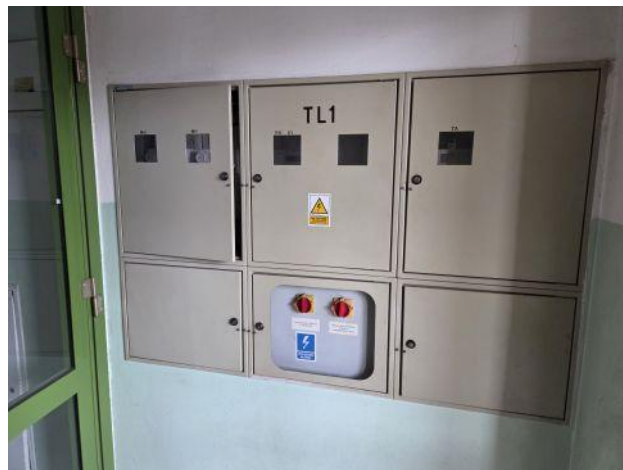
Fot. 16 Główny wyłącznik prądu, znajdujący się przy wejściu do budynku
