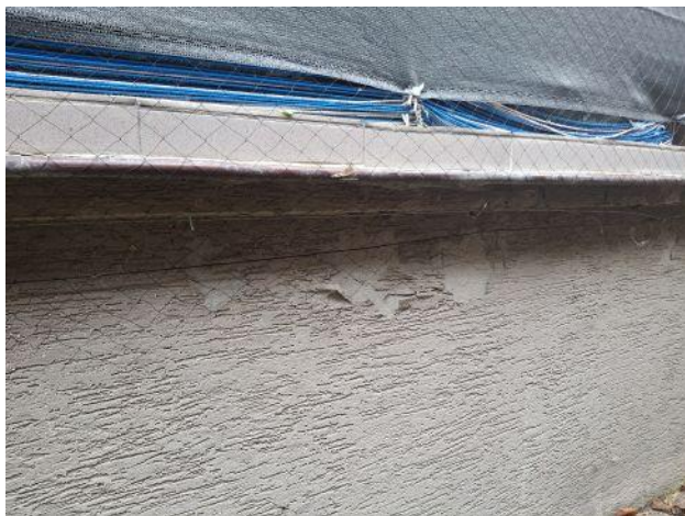
Fot. 15 Przekorodowane obróbki blacharskie przy balkonie w lokalu nr 2
