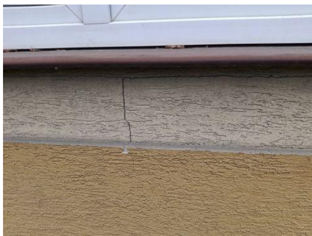
Fot. 7 Lokalne rysy ścian zewnętrznych
