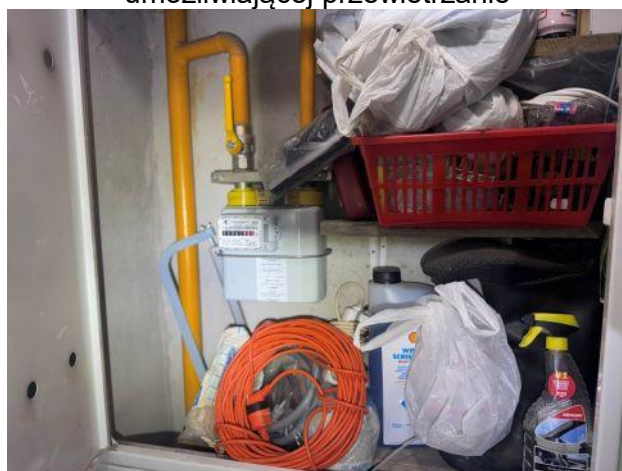
Fot. 30 Niedozwolone umieszczenie materiałów w szafce gazowej
