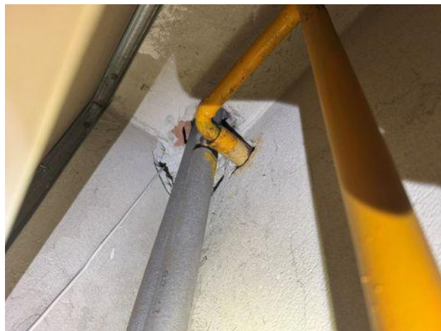
Fot. 28 Na poziomie parteru rury prowadzone nad sufitem powieszanym – brak perforacji umożliwiającej przewietrzanie
