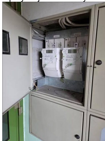
Fot. 18 Liczniki i Wyłączniki główne tablic usługowych RU, R-U1, oraz tablic mieszkaniowych M-1, M-2
