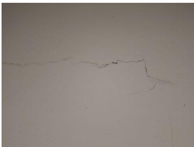
Fot. 11 Lokalne rysy ścian klatki schodowej
