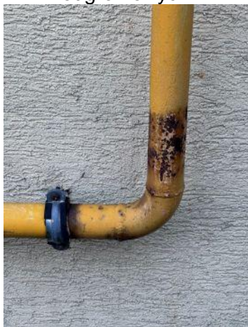
Fot. 25 Skorodowana rura stalowa instalacji gazowej, prowadzona po zewnętrznej ścianie budynku
