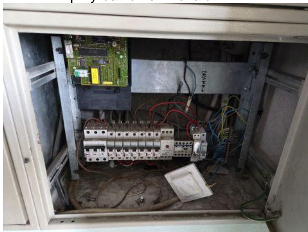
Fot. 17 Niezabezpieczona tablica TA, stwarzająca zagrożenie porażeniem prądem
