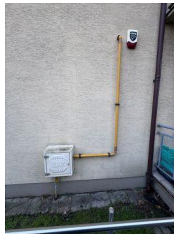
Fot. 26 Skorodowana rura stalowa instalacji gazowej, prowadzona po zewnętrznej ścianie budynku
