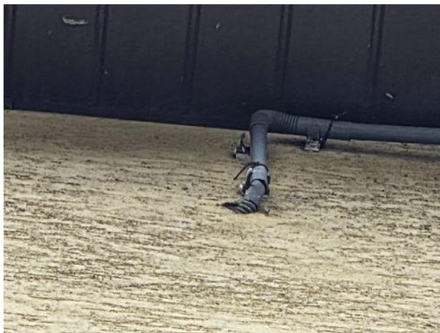
Fot. 21 Instalacja odgromowa - zwody pionowe poprowadzone w elewacji w zwykłych rurkach, zamiast iskrobezpiecznych
